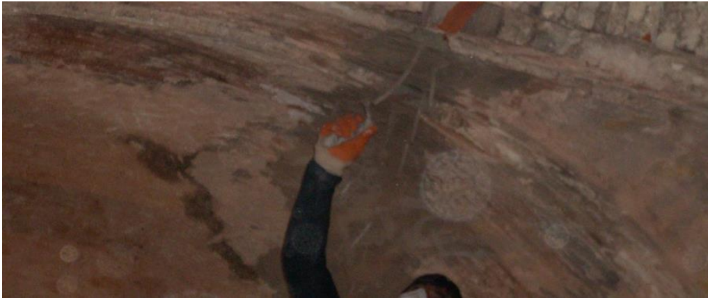
Hidrolik Kireç esaslı Enjeksiyon yöntemi
