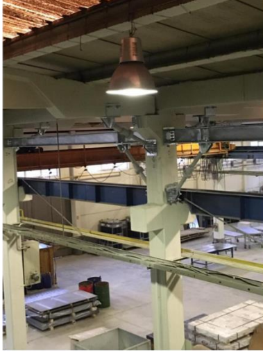
Sanayi Tesislerinde Güçlendirme
