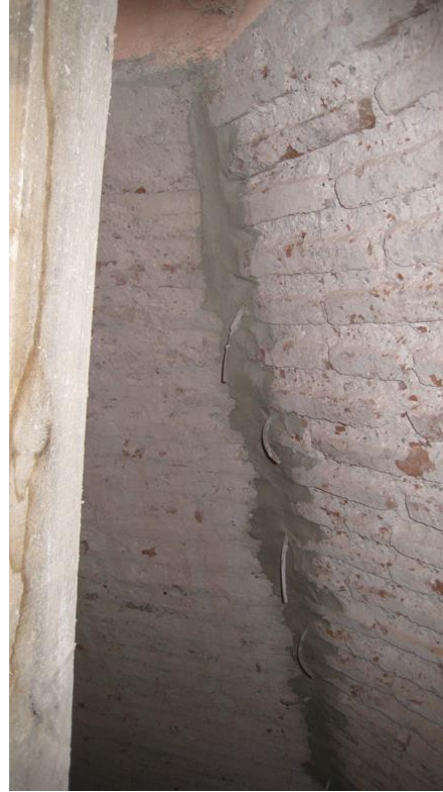
Tarihi yapılarda çatlak enjeksiyonu duvar çatlakları
