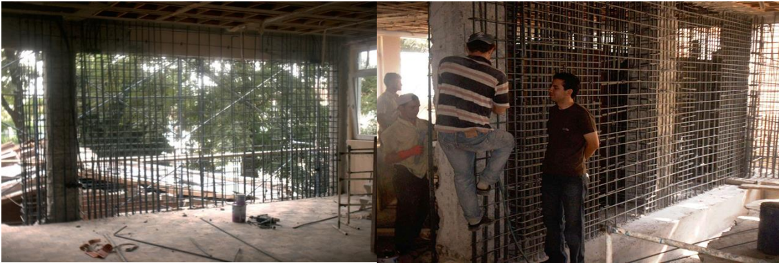
Şekil 9. Betonarme perdeler ile güçlendirme
