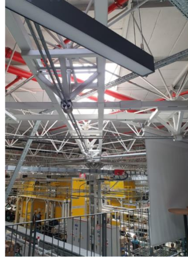
Uzay Çatı Ardgerme ile Güçlendirme
