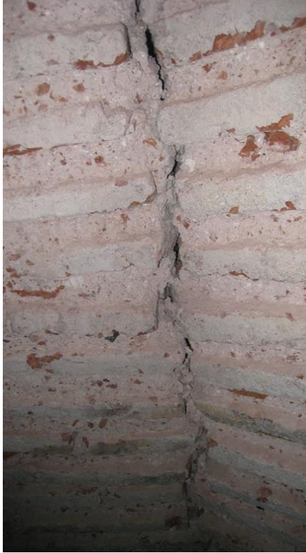
Tarihi yapılarda çatlak enjeksiyonu duvar çatlakları
