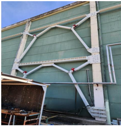
Prefabrik Yapıda Yapı Dışından Sönümleyici ile Güçlendirme
