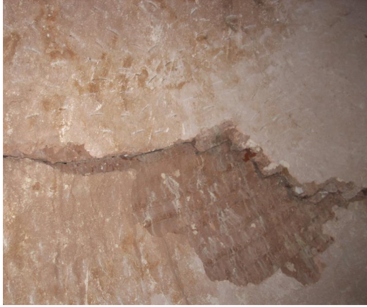
Tarihi yapılarda çatlak enjeksiyonu kubbe çatlakları
